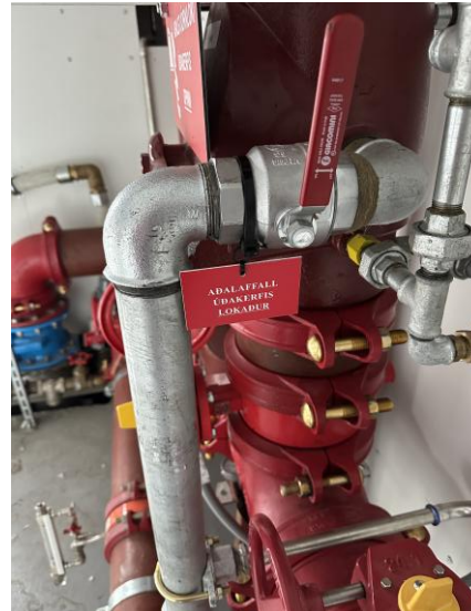
Stýringar á úðakerfi Skútuvogs 9
